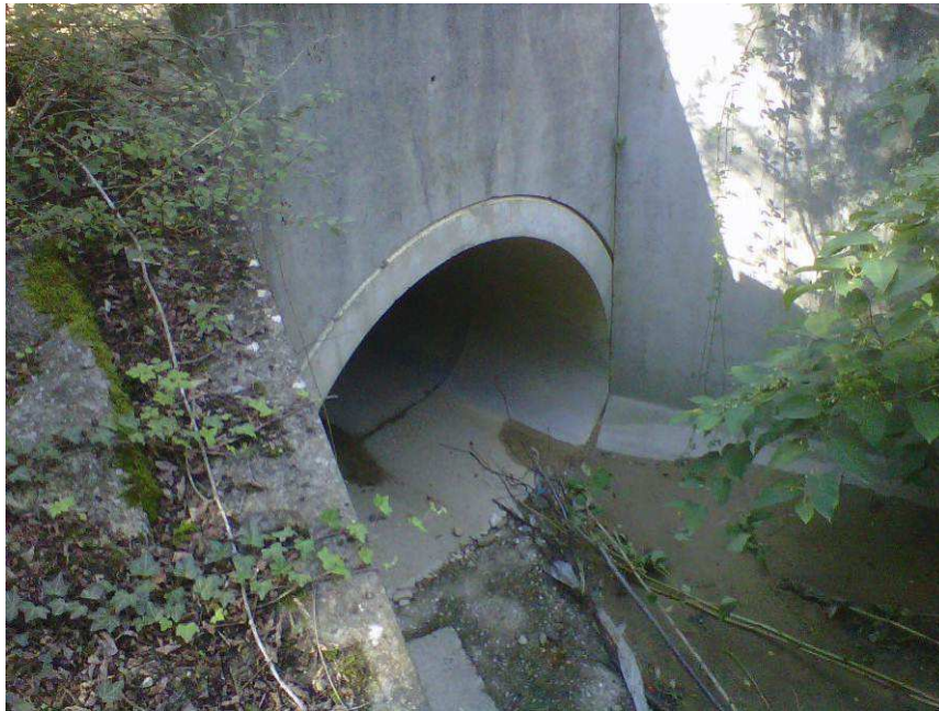
Exutoire du bassin de rétention où sera posée la vanne murale
