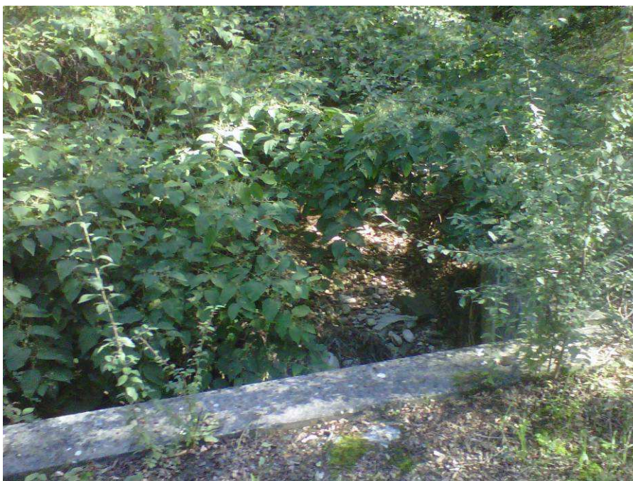
Renouée du Japon dans le bassin de rétention présent sur l'Abereau
