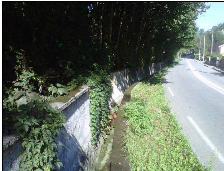
Cuvelage du cours d'eau entre le mur et la route
