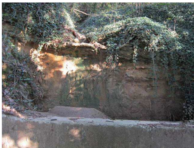
Lieu d'implantation du bassin de décantation
