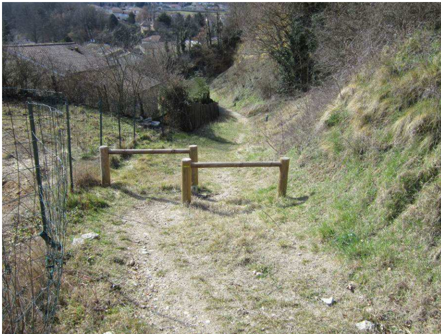
Chemin d'accès utilisable pour l'exploitation du piège à sédiments
