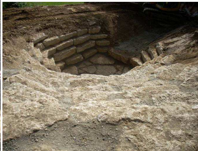
Exemple de dissipateur d'énergie
