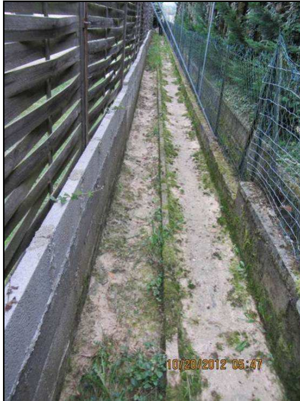
Traversée entre les habitations, secteur provoquant des inondations
